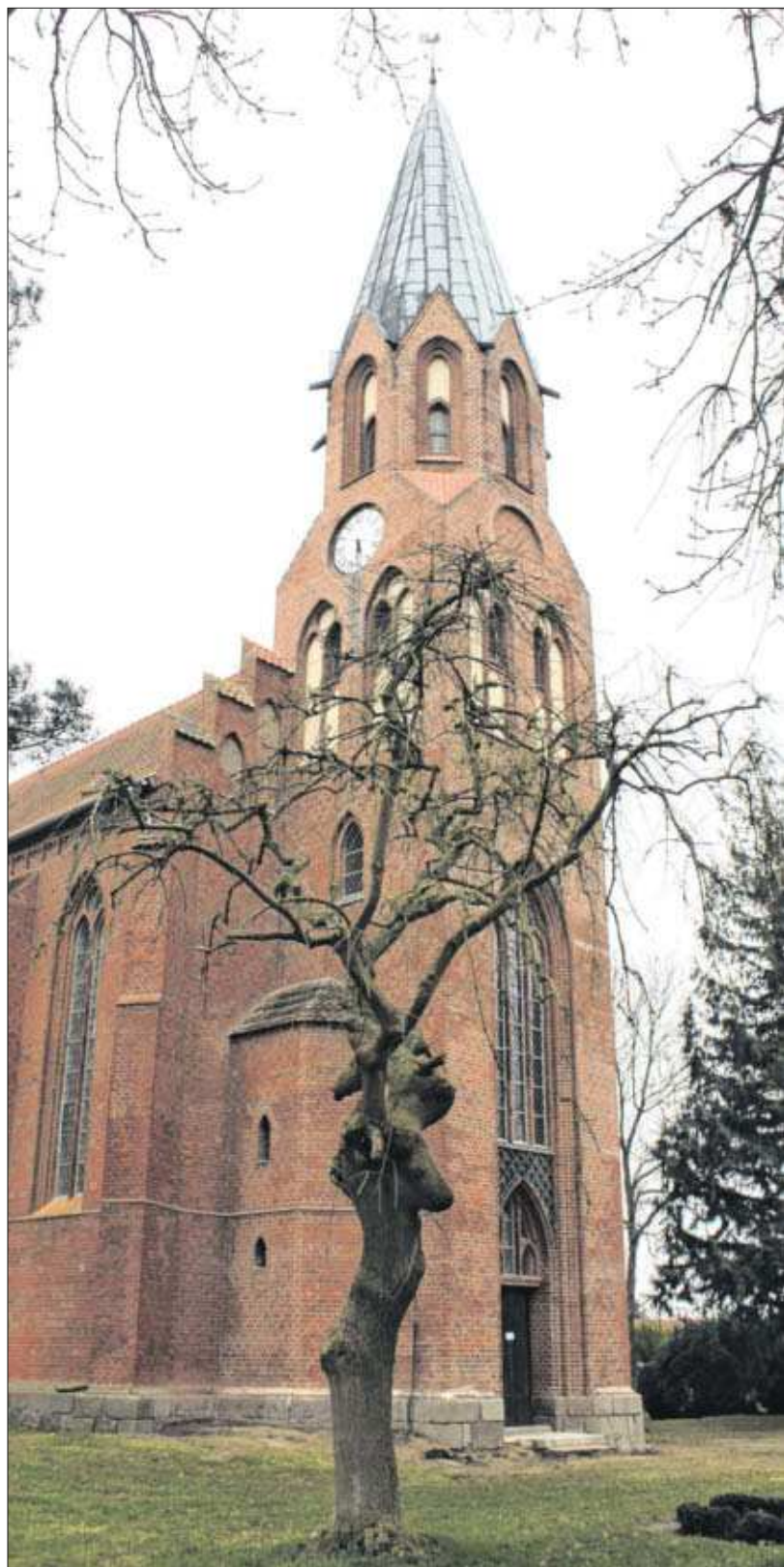
Das Pantlitzer Gotteshaus erstrahlt pünktlich zum Fest in neuem Glanz: Das Gerüst ist abgebaut, der Turm saniert. Auch zwei Fenster auf der Nordseite wurden erneuert. Sie zeigen historische Details, wie die Stifterscheiben.
